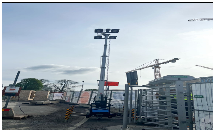
Figur 17. Inhägnad med staket runt bodarna byggarbetsplats i projekt B.
