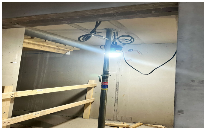
Figur 9. Översiktsbild över trapphuset i projekt A.
