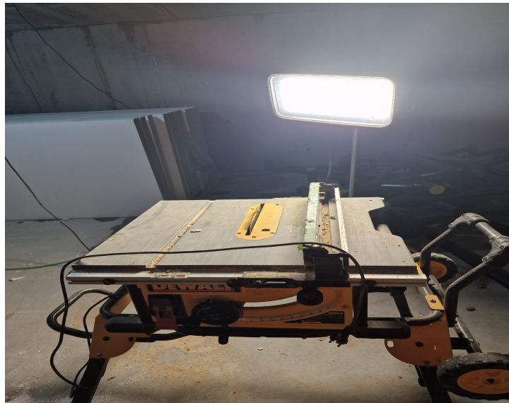
Figur 16. Arbetslampa monterad vid arbetsbänken.
