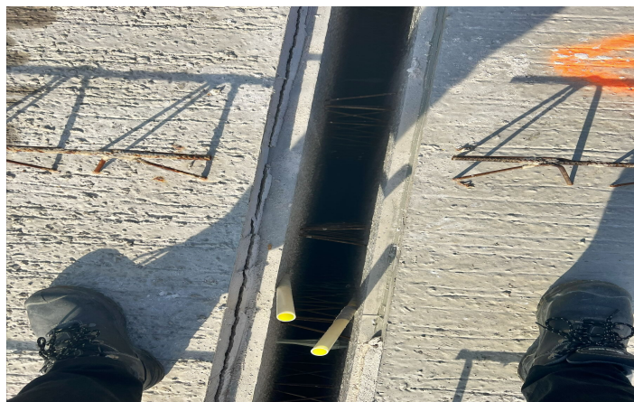
Figur 15. Visar håll mellan två betongplattor.
