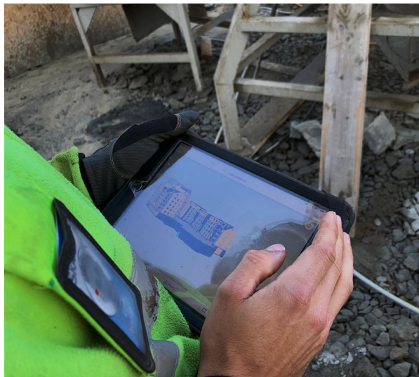
Figur 15. Surfplattor med uppkoppling till BIM 360. Foto från extern intervju.
